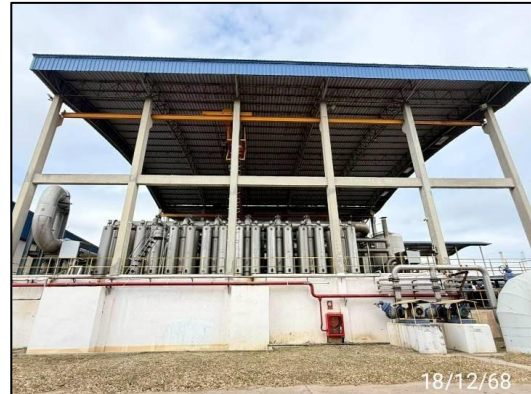
รูปที่ 2-13 โรงกรองน้ำเพื่อผลิตน้ำประปา
