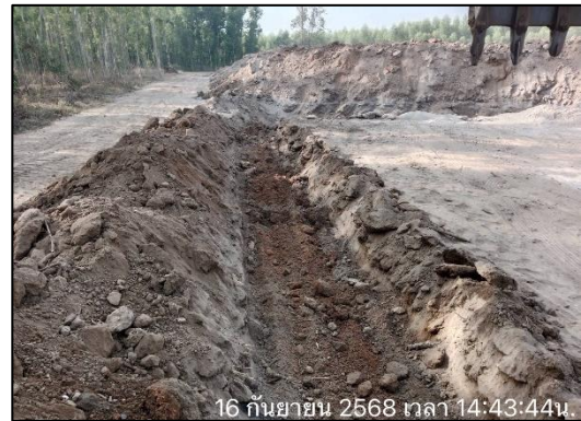
รูปที่ 2-21 ค้นดินล้อมแปลงปลูกยูคาลิปตัส
