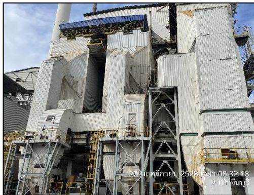
รูปที่ 2-6 ระบบดักฝุ่นแบบไฟฟ้าสถิต (ESP)
